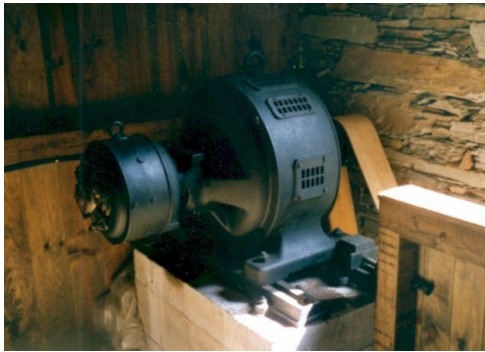
Alternador empregado para a produción eléctrica na ferreiría de Bogo (A Pontenova)
